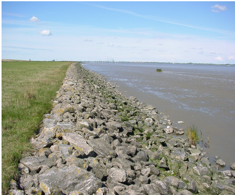
Deckwerk in Wasserwechselzone
