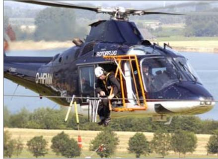
Anbringung von Signalfahnen an bestehenden Freileitungen mit Hilfe eines speziell umgebauten Hubschraubers
