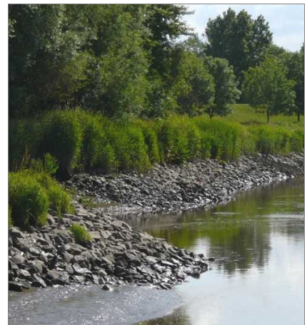
Uferdeckwerk bei Kasenort
